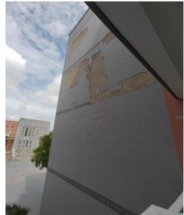
图 6-87 瓷砖脱落
