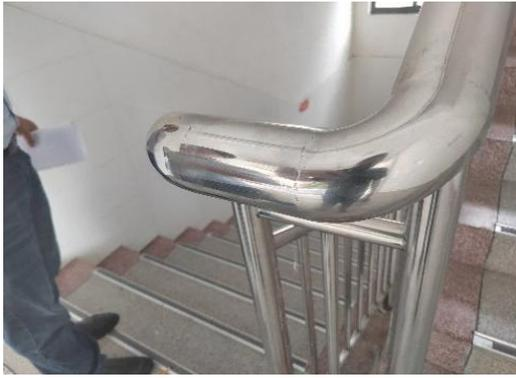
图 6-72 扶手弯头接口维修
