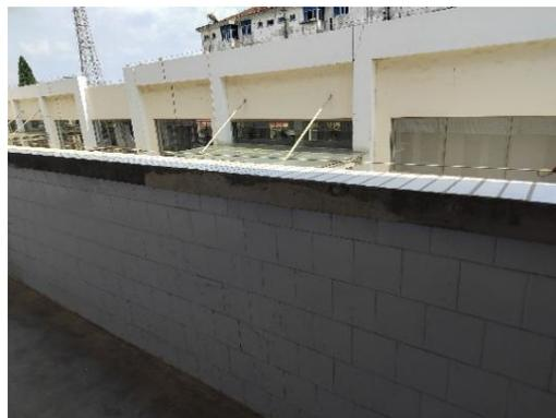
图 6-53 瓷砖剥落
