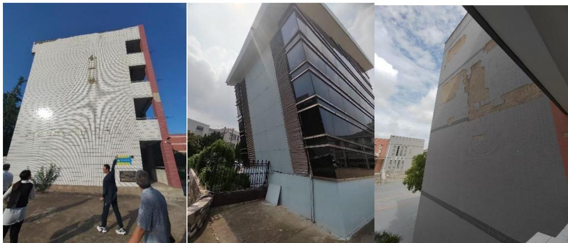
图 6-100 瓷砖脱落
