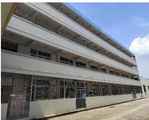
图 6-54 两幢教学楼外墙喷真石漆
