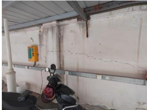
图 6-104 墙面开裂
