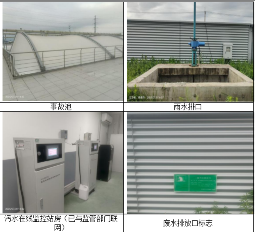
图 2-7 废水处理构筑物
