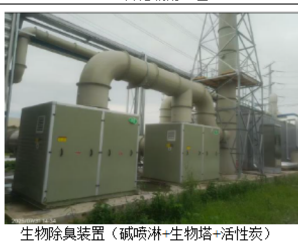
图 2-15 已批已建废气处理设施
