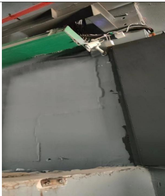
危废仓库内部摄像头
